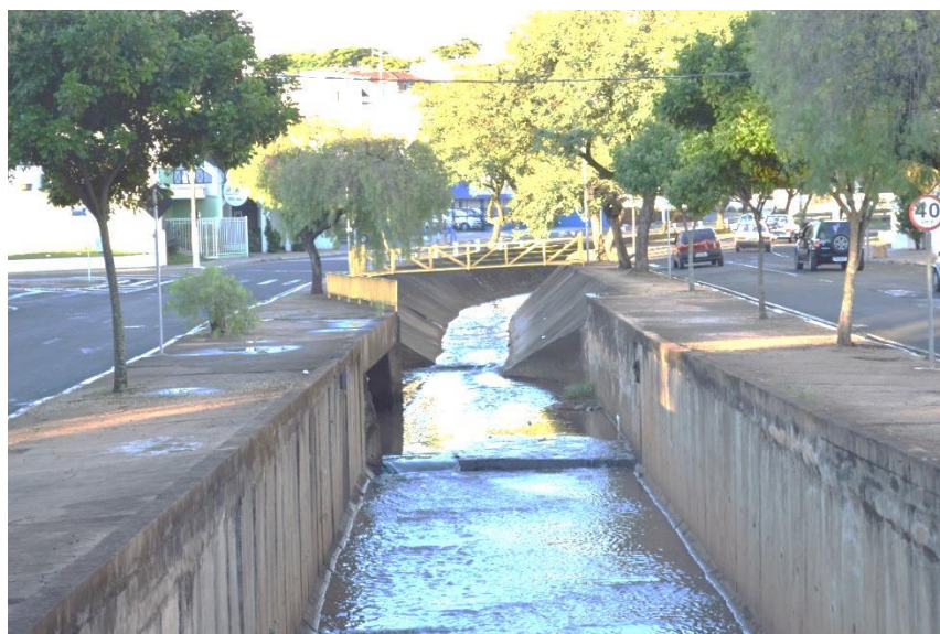
Figura 1 – Canalização do Córrego Cubatão em Franca(SP)
